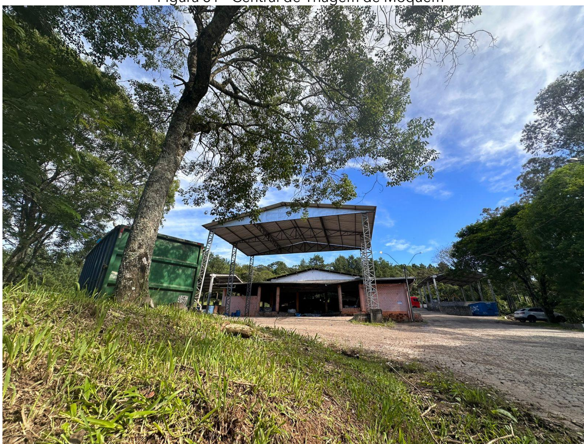
Figura 31 - Central de Triagem de Moqué
