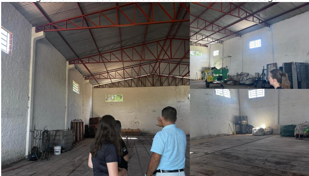
Figura 70 - Pavilhão onde serão recebidos resíduos de reciclagem
