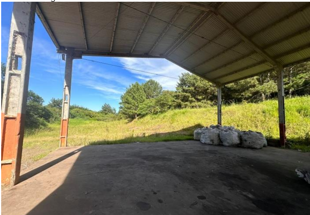
Figura 34 - Pavilhão de armazenagem de resíduos triados
