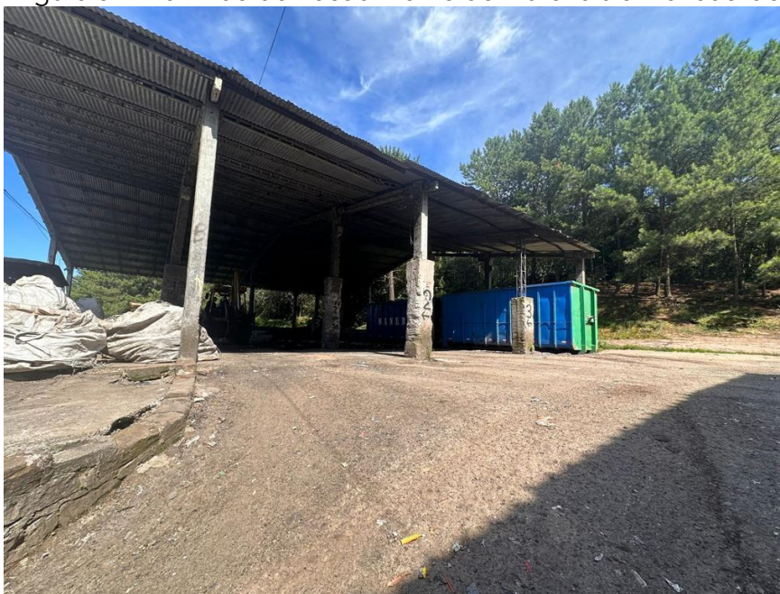
Figura 32 - Pavilhão de Recebimento de Materiais e Transbordo
