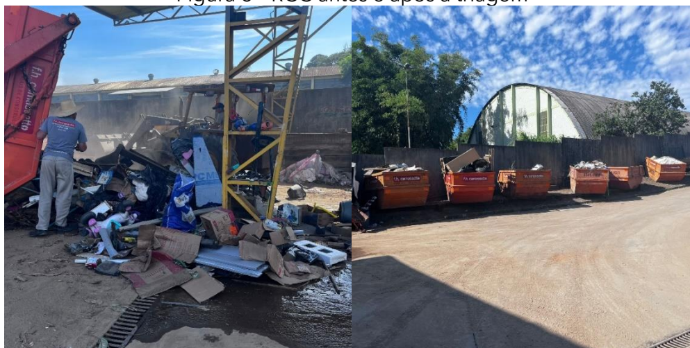
Figura 8 - RCC antes e após a triagem
